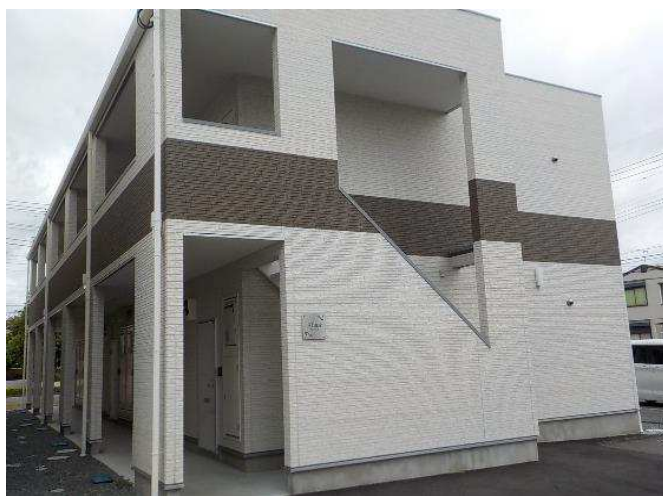
ステーションの外観(101号室)
